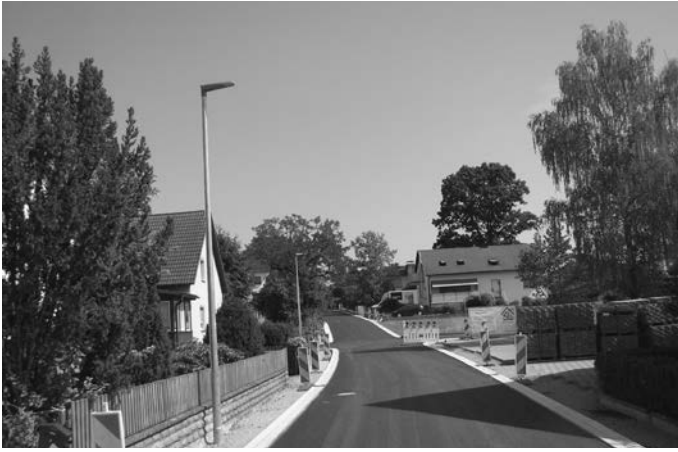
Die Arbeiten im Ossangerweg sind weit fortgeschritten. Neue LED-Leuchten zieren das Straßenbild.
